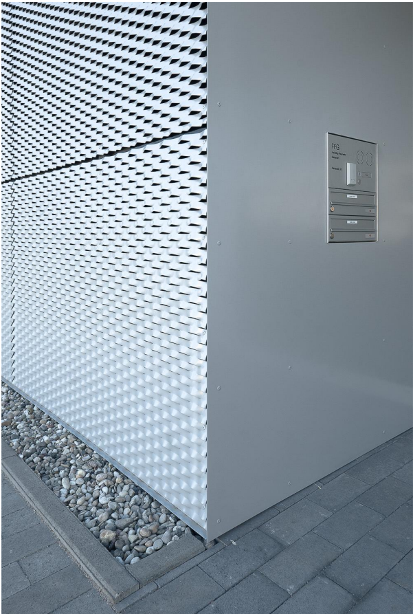
Detailansicht Eingang / Bereitschaft
