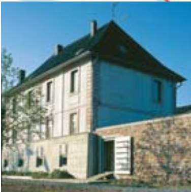
Maßnahme: Hochwasserschutz Würth Kategorie: Technischer Hochwasserschutz – Bestand Kosten: 13.500.000 Euro Ort: Würth am Main Gewässer: Main
